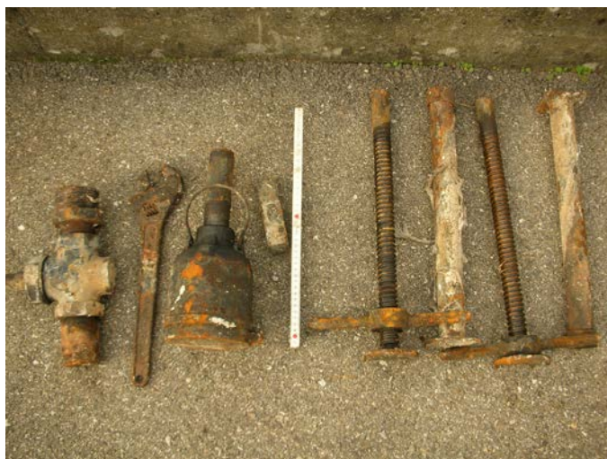
Gegenstände die aus dem Düker entfernt wurden!!!
