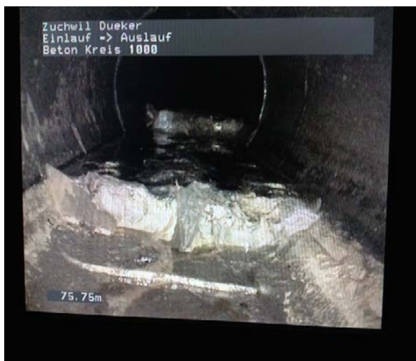
Ablagerungen im Auslaufbereich
