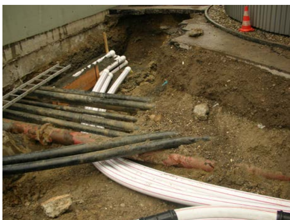
Umlegung der Werkleitungen. Alle Anlagen sind immer in Betrieb!
